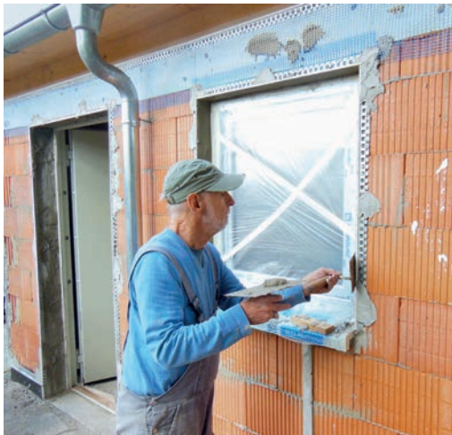
Bau Toiletten & Funktionsraum 2022
