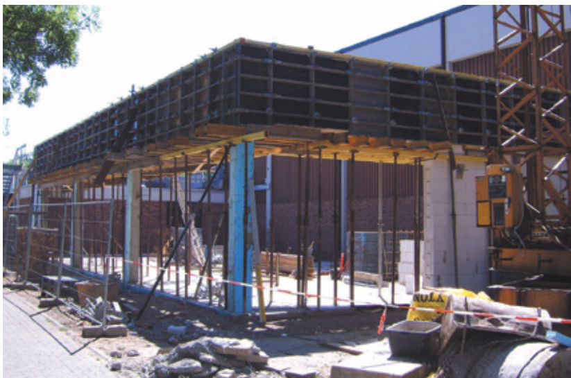
Schon gut zu erkennen sind am Rohbau die offenen, großflächigen Fensterbereiche für eine Licht durchflutete, helle und freundliche Studioatmosphäre.
